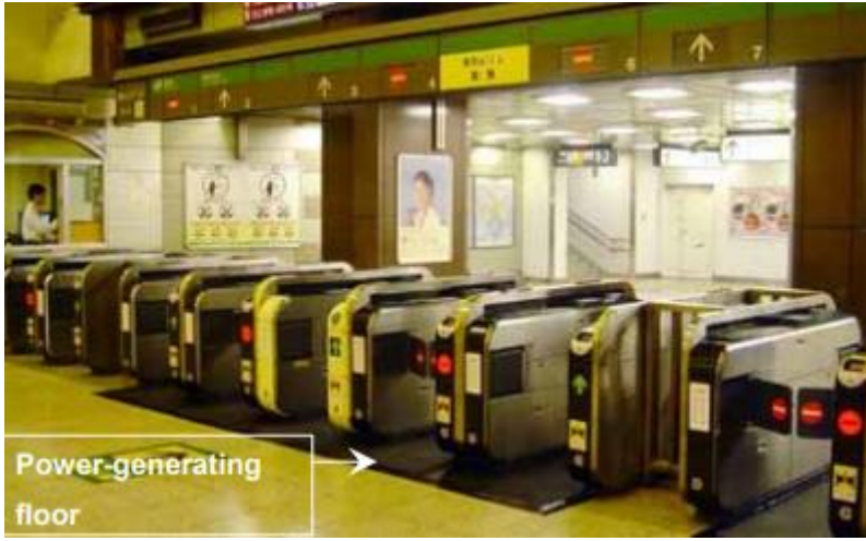
Şekil 54 Tokyo Tren istasyon turnike girişi zeminine yerleştirilmiş piezoelektrik zemin 71
