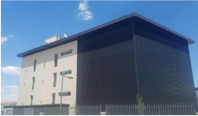
Şekil 53 Ankara Sincan-Etimesgut Tapu ve Kadastro Genel Müdürlüğü Hizmet Binası cephesine kurulu güneş duvarı teknolojisi örneği
