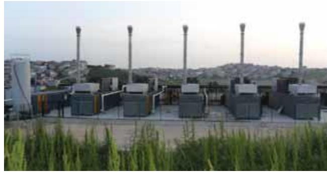
ŞEKİL 4-7:YENİKENT KATI ATIK TESİSİ METAN GAZINDAN ENERJİ ELDESİ
