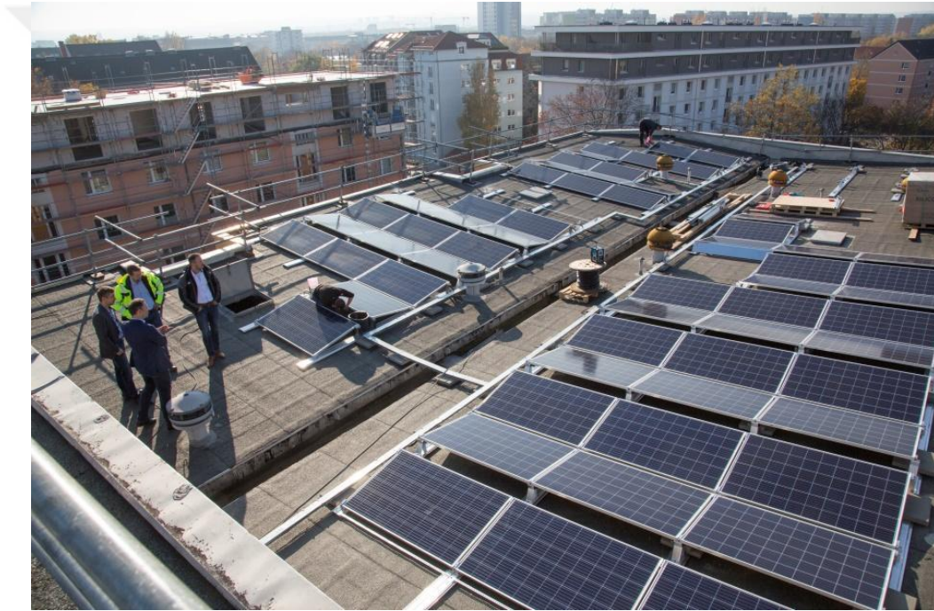
Şekil 4.49. Pfotenhauer Caddesi'ndeki binalara kurulan fotovoltaik paneller (Breß, 2020)
