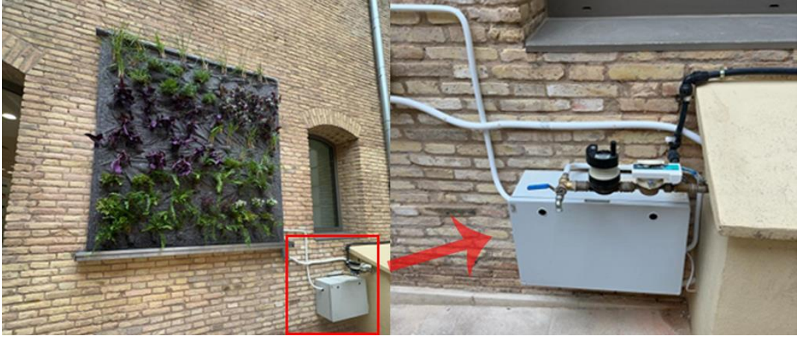
Şekil 4.41. Las Naves binasındaki dikey bahçe için geliştirilen akıllı sulama sistemi
