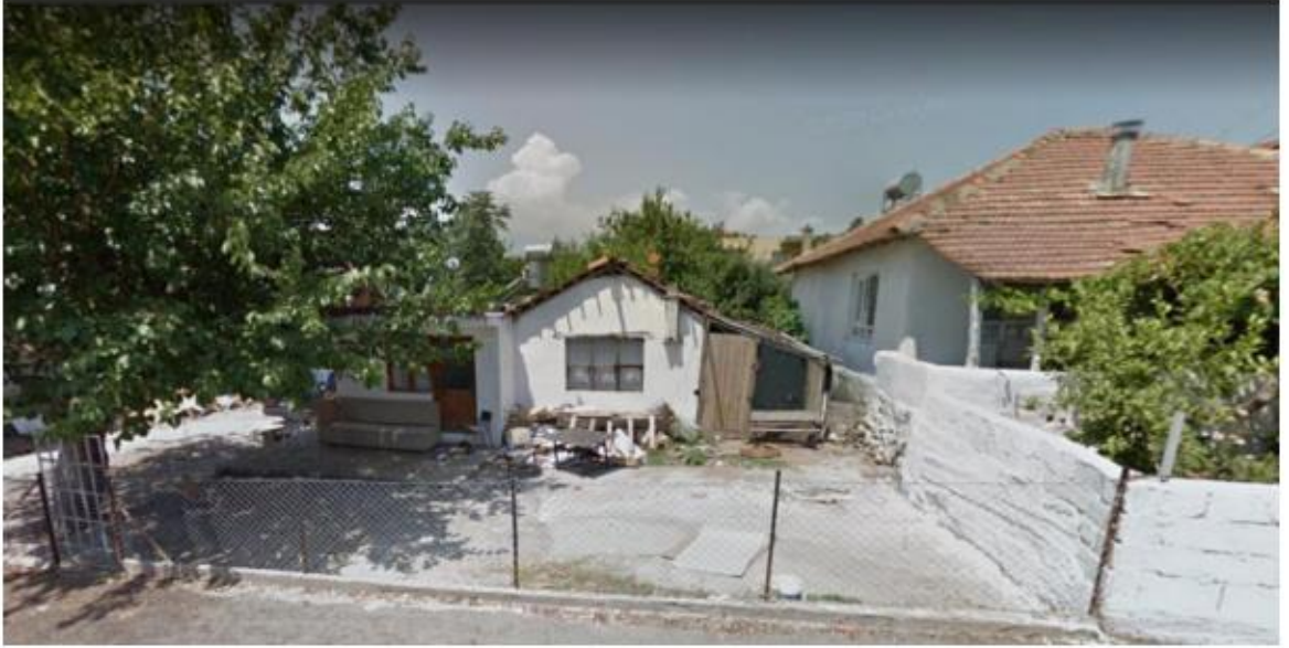
Şekil 4.68. Kentsel dönüşüm öncesi riskli bir yapıdan görünüş (Özçandır ve Ateş Can, 2022)
