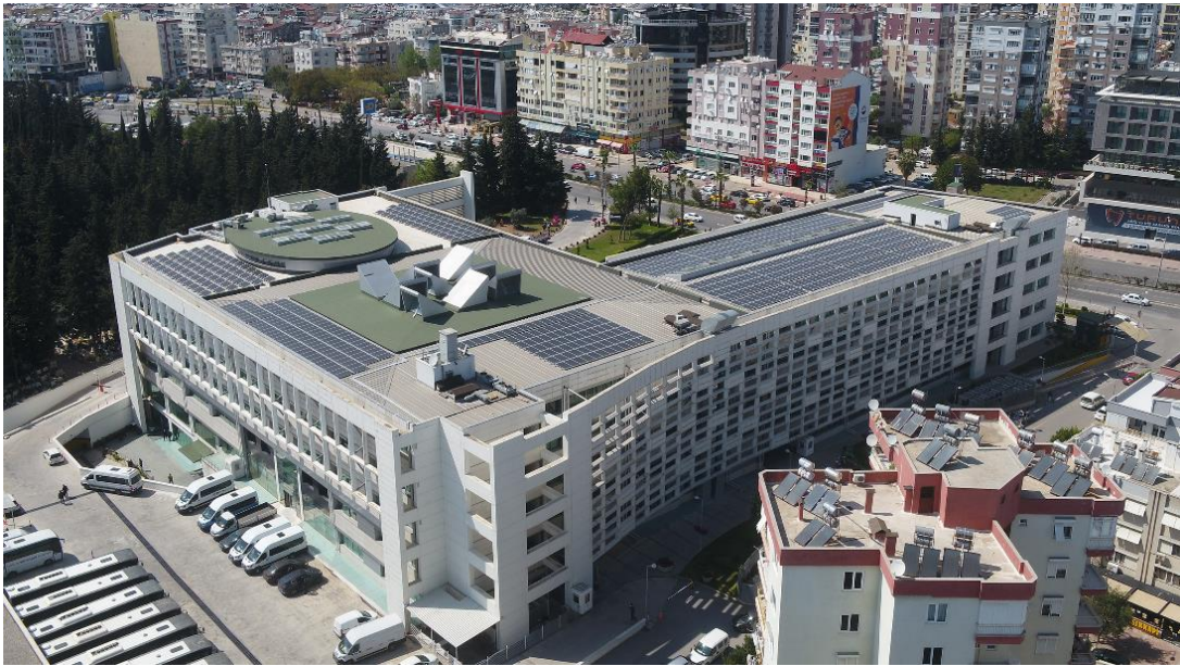
Şekil 4.78. Antalya Büyükşehir Belediyesi Ana Hizmet Binası çatı tipi GES (Antalya Büyükşehir Belediyesi, 2023b)
