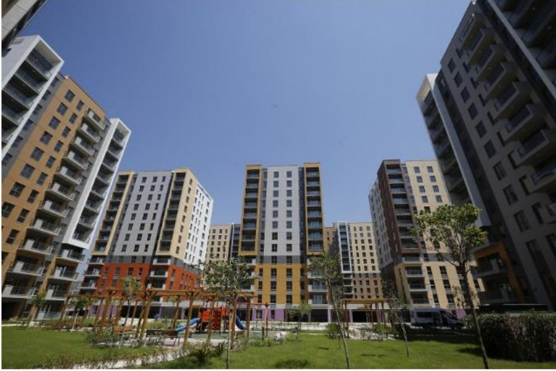
Şekil 4.74. Kepez-Santral Mahallelerinde akıllı ev sistemleri kurulan konut blokları
